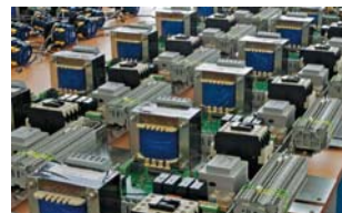
Цех сборки электрооборудования
