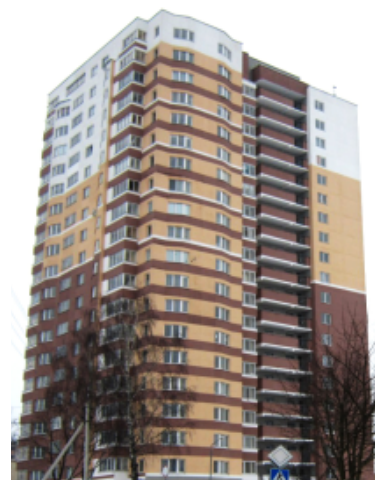
Жилой дом ул. Корвата
