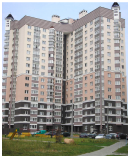
Жилой дом ул. Бурдейного
