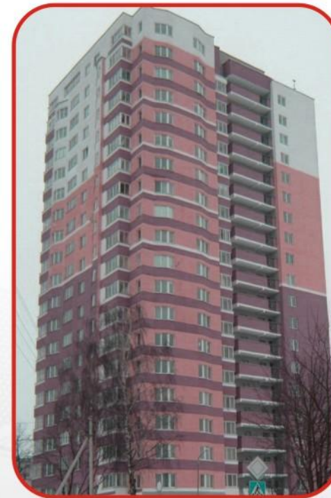
Жилой дом ул. Бумажкова (г. Минск)
