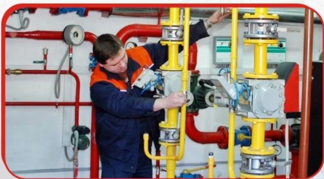
монтаж систем внутридомового газоснабжения
