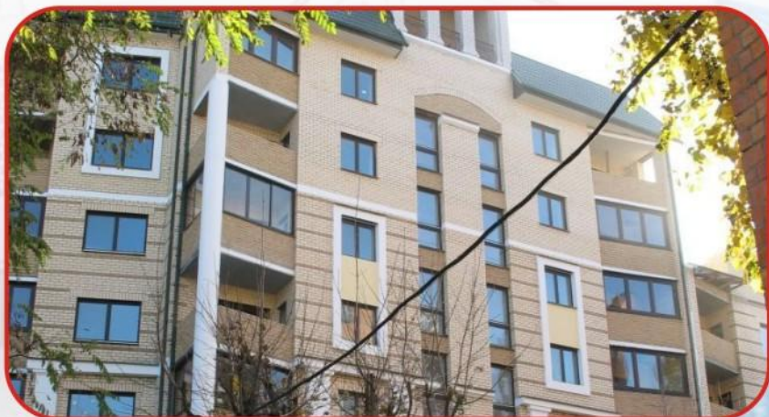
Жилой дом ул. Комсомольская (г. Брест)
