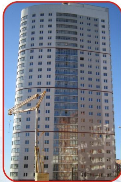
Жилой дом ул. Ложинская (г. Минск)
