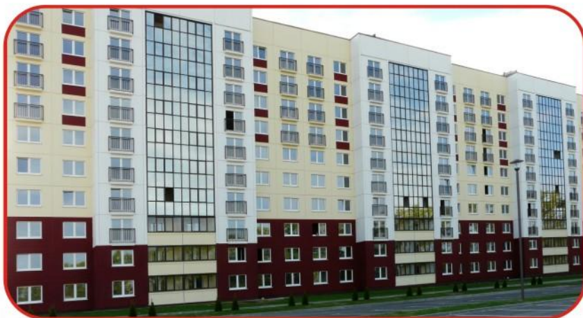
Жилой дом г. Балабаново (Калужская обл.)
