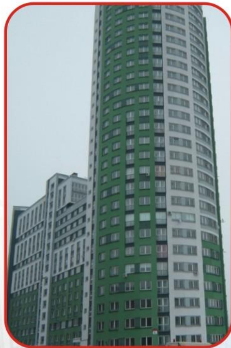
Комплекс "Каскад" ул. Кальварийская (г. Минск)
