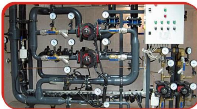
монтаж индивидуальных тепловых пунктов
