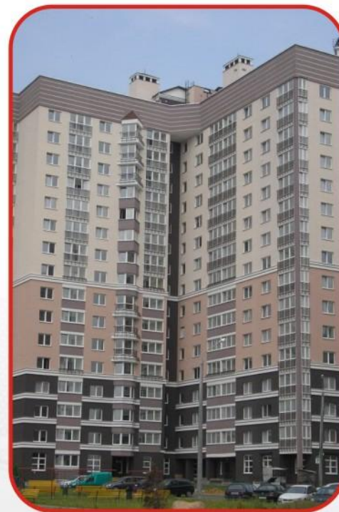
Жилой дом ул. Бурдейного (г. Минск)
