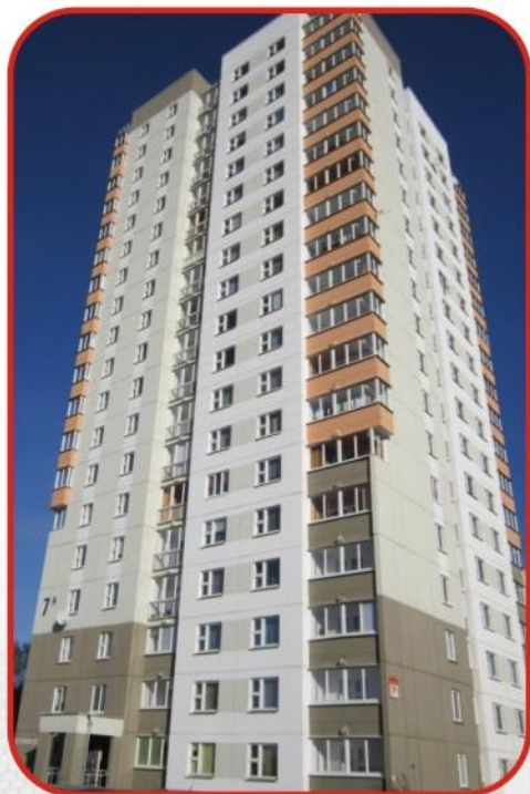
Жилой дом ул. Макаёнка (г. Минск)
