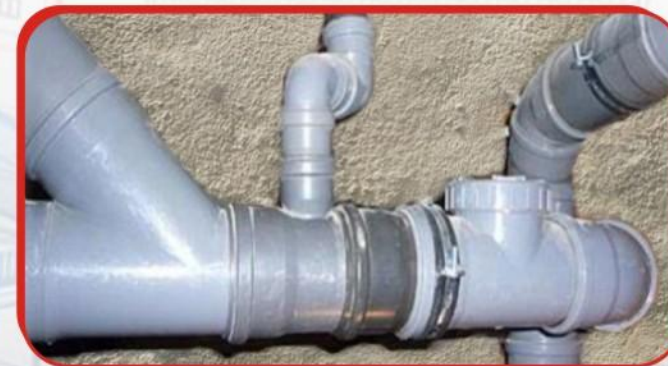
монтаж внутренних систем канализации
