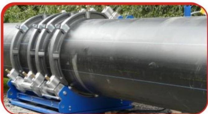
монтаж наружных систем водопровода и канализации
