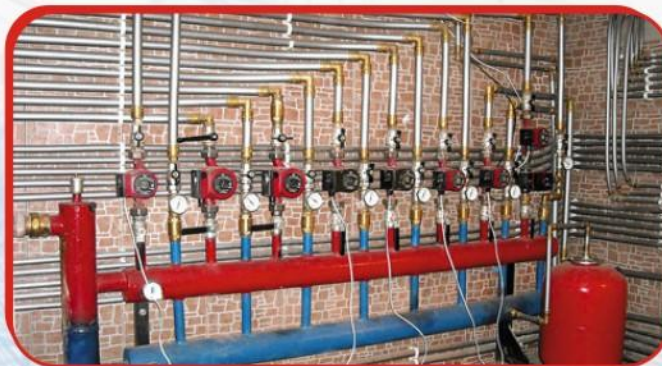
монтаж внутренних систем водопровода
