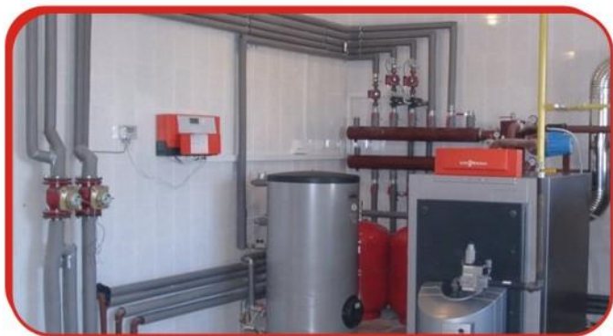
монтаж и пуско-наладка котельных
