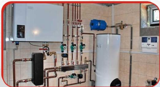
монтаж внутренних систем отопления
