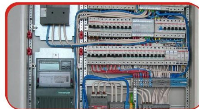
монтаж систем электроснабжения и освещения
