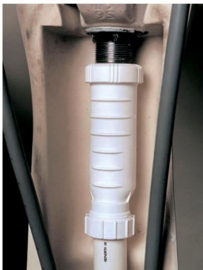
Рисунок 8. Ориентация трапа Нерво® при горизонтальной установке
