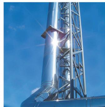
Дымовые трубы котельных представляют собой сложные инженерные сооружения, поэтому работы по их проектированию, строительству и эксплуатации требуют комплексного решения большого количества технических задач, в числе которых необходимость надежной тепловой изоляции. Для промышленного использования идеально подходят дымоходы серии Craft 316, изготавливаемые из кислотостойкой и жаропрочной аустенитной стали AISI 316.
