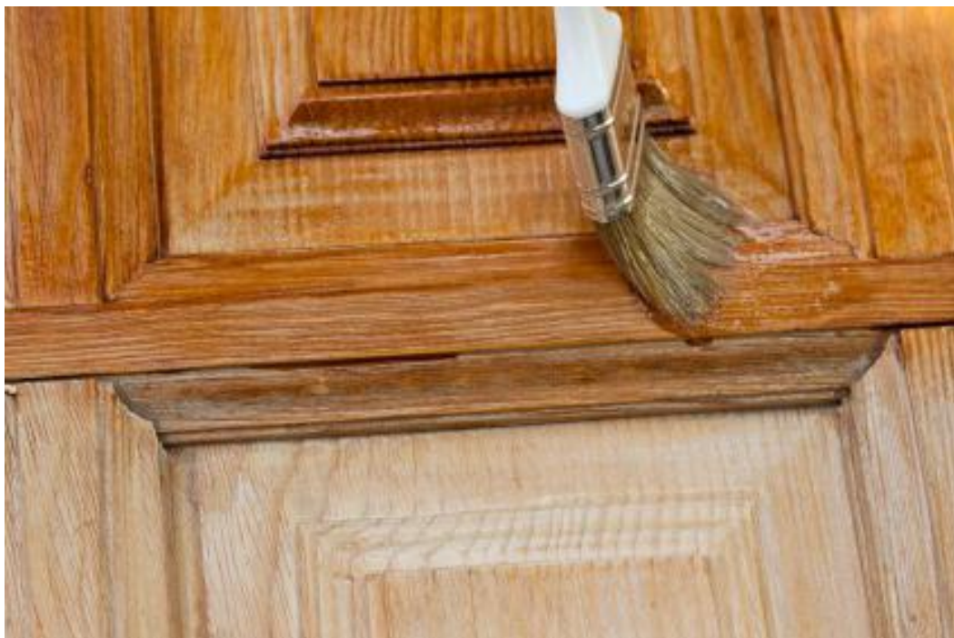
Рисунок 109 – Нанесение масляно-воскового состава на дверь кистью ( http://rubankom.com )
