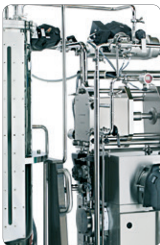
Линия подачи раствора
