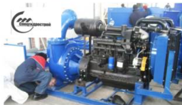
Строительство/ Московская обл.
