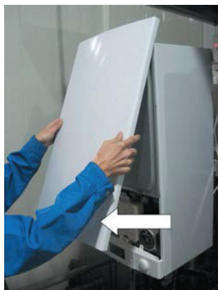
4. Поднимите вверх и снимите переднюю панель.
