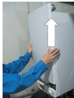
3. Передвиньте переднюю панель вверх и вперед.
