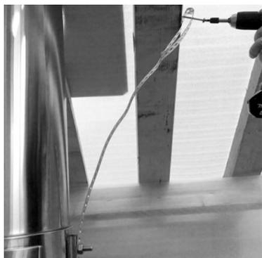
10. Установите вторую секцию метровой дымовой трубы (деталь 2) и затяните соединение с помощью хомута (деталь 6). Закрепите монтажную ленту на хомуте и прикрепите к стропилам с помощью винтов.
