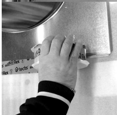
11. Прикрепите подкладочный лист (деталь 7) к подкладке, оставляя воздушный зазор 10 мм от поверхности трубы. Зазор между краем поднятой подкладки и трубой дымохода остается открытым для вентиляции.
