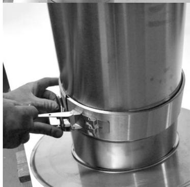
4. Поместите хомут (деталь 9) на соединительный элемент заслонки (деталь 1) и дымовую трубу (деталь 2) и надежно затяните его.
