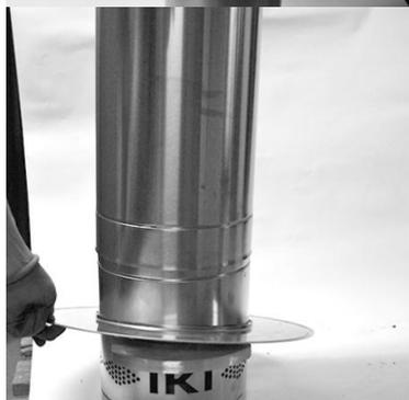
3. Поместите дымовую трубу (деталь 2) непосредственно на верхней части заслонки (деталь 1). На данном этапе установки потолочное кольцо может просто лежать на верхней части заслонки.
