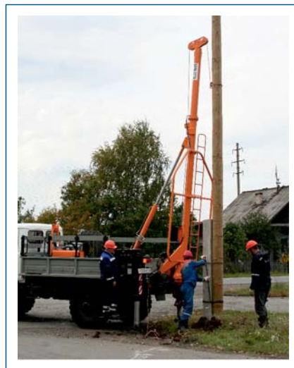
Машина способна производить монтаж опоры
