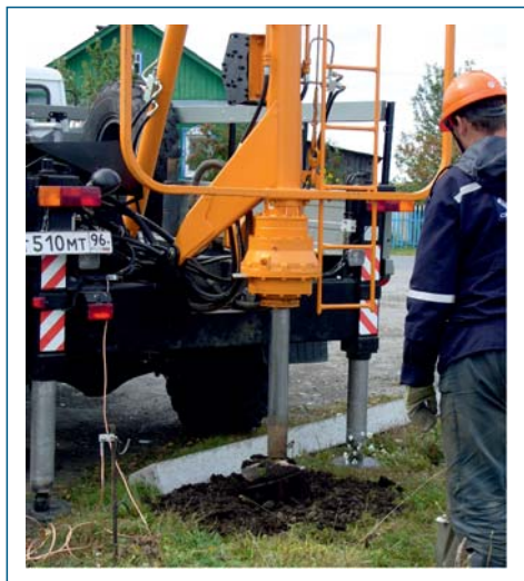
Бурение лопастным буром в грунтах до VII категории
