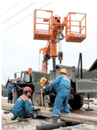
Перевозка опоры ЛЭП
