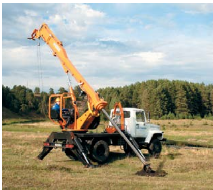
Бурение скважины на МРСК-311 с поворотом платформы
