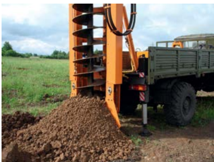
Бурение скважины на МБШ-519
