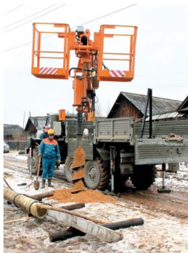
Бурение скважины
