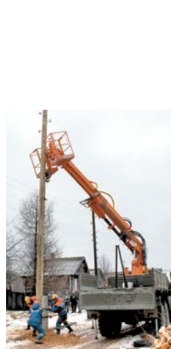
Установка опоры
