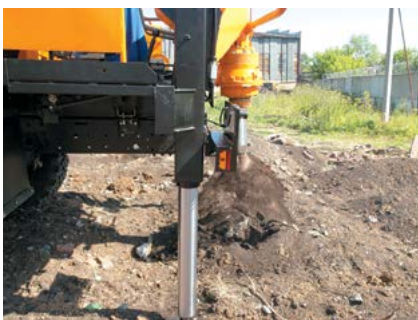
Разброс грунта при бурении на БКМ-516
