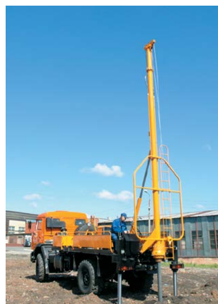
Бурение скважины на БКМ-516
