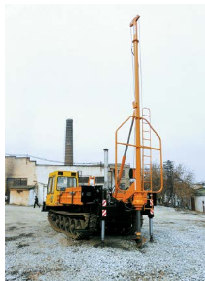
Бурение скважины на БКМ-534А
