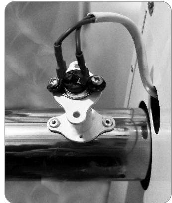
Рис. 4. Установка датчика тяги.
