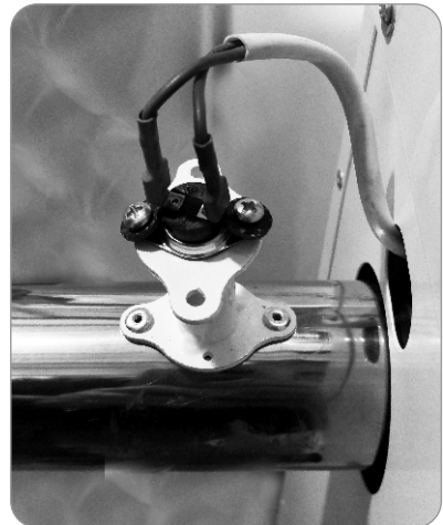
Рис. 3. Установка датчика тяги.
