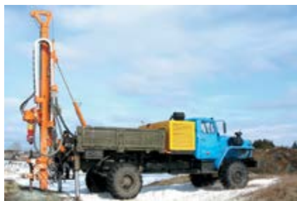
БГМ-12 на шасси Урал при бурении скважины на воду
