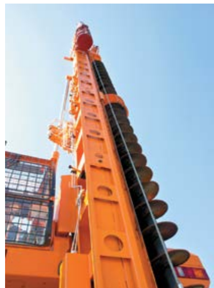
Бурение скважины на БМ-831М
