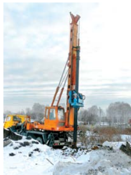
Бурение скважины на БКМ-2012
