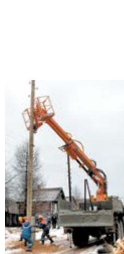
Установка опоры
