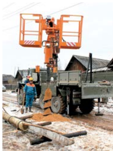
Бурение скважины
