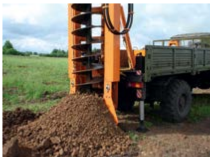
Бурение скважины на МБШ-519
