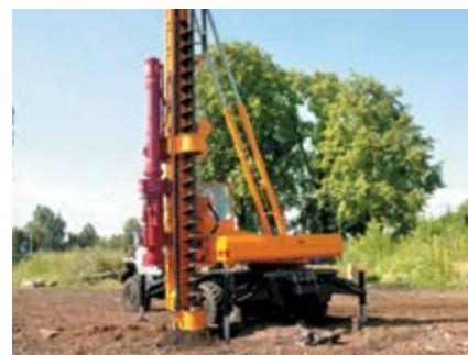
Бурение скважины на БМ-811М
