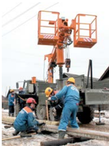
Перевозка опоры ЛЭП
