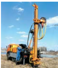
Бурение скважины на УРБ-51
