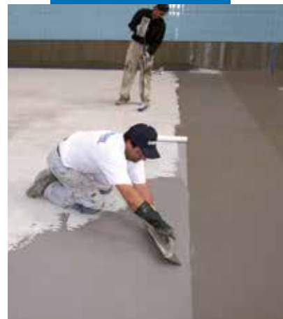
Гидроизоляция бассейна с помощью Mapelastic
