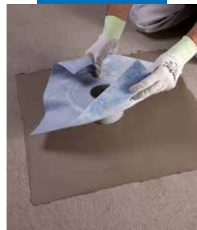
Укладка Drain Vertical на Mapelastic
