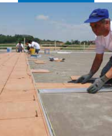
Укладка керамики с помощью Kerabond + Isolastic
