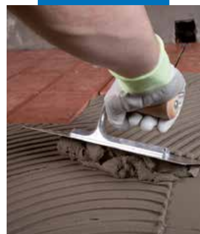
Укладка Granirapid на террасу, гидроизолированную с помощью Mapelastic
