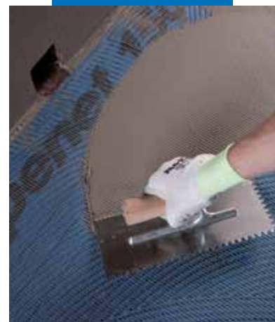
Нанесение Mapelastic на Mapenet 150
