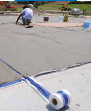
Гидроизоляция стяжек с помощью Mapelastic и Mapeband
