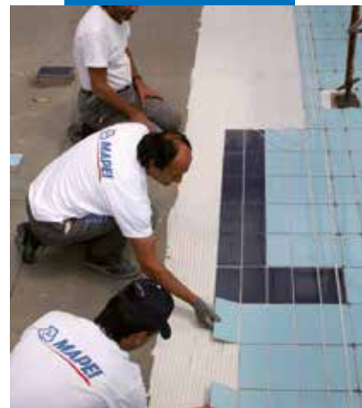
Укладка керамической плитки поверх Mapelastic в бассейне
