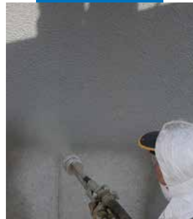
Пример нанесения Mapelastic на виадук с помощью распылителя
