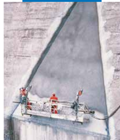
Пример нанесения Mapelastic на дамбу с помощью распылителя
