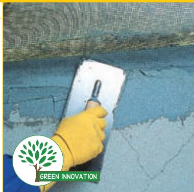
**Двухкомпонентный эластичный состав на цементной основе для гидроизоляции балконов, террас, ванных комнат и плавательных бассейнов.**
