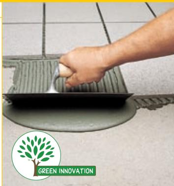
Высококачественный деформативный быстросхватывающийся двухкомпонентный клей на цементной основе для укладки керамической плитки и натурального камня.
