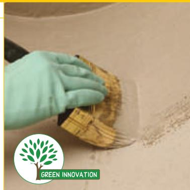
**Двухкомпонентный высокозластичный состав на цементной основе для гидроизоляции бетонных поверхностей, балконов, террас, ванн и плавательных бассейнов. Наносится кистью или валиком.**
