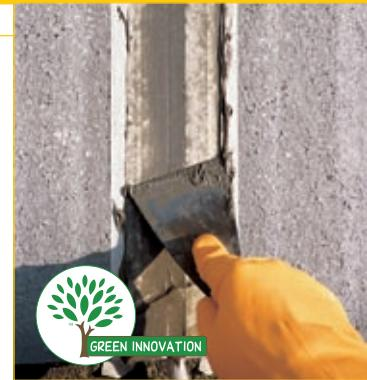
**Двухкомпонентный тиксотропный полиуретановый герметик для швов с рабочим расширением / сжатием до 10%.**
