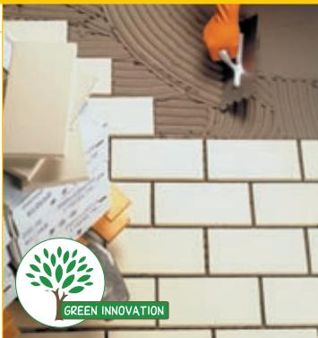
Высокодеформативный высококачественный быстросхватывающийся двухкомпонентный клей на цементной основе с увеличенным открытым временем, без вертикального оползания. Предназначен для укладки керамической плитки и натурального камня.
