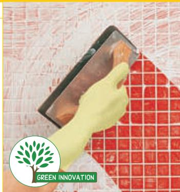
Высококачественный заполнитель на цементной основе для шов шириной до 4 мм. Образует швы с идеально гладкой поверхностью.
