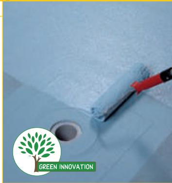
**Готовая к применению быстросохнущая эластичная жидкая мембрана для внутренней и наружной гидроизоляции.**
