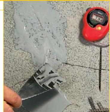
**Очень быстро схватывающаяся двухкомпонентная полиэтиловая смола.**
