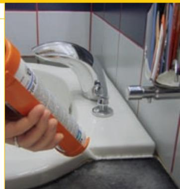
Силиконовый герметик на основе уксусной полимеризации для санитарной герметизации.
