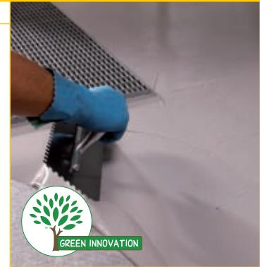
**Однокомпонентный высокозластичный цементный состав для гидроизоляции бетона, балконов, террас, ванных комнат и плавательных бассейнов.**
