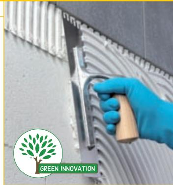
Высококачественный готовый к использованию пастообразный клей для керамической плитки, без оползания на вертикальных поверхностях, с продленным временем на внесение исправлений и продленным открытым временем. Идеален для укладки на впитывающие основания.
