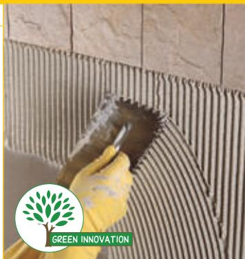
**Улучшенный клей на цементной основе без оползания на вертикальных поверхностях, с увеличенным открытым временем. Предназначен для укладки керамической плитки.**
