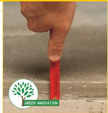
**Быстрохватывающаяся самовыравнивающаяся смесь с толщиной нанесения от 3 мм до 30 мм.**
