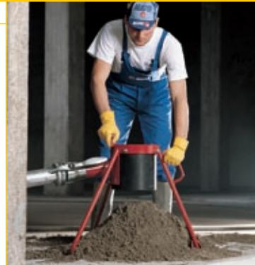
Специальное быстросохнущее гидравлическое вяжущее для изготовления стяжек с нормальным временем схватывания, быстрым высыханием (4 дня) и контролируемой усадкой.
