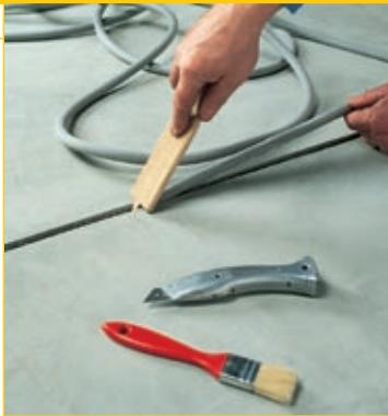
Шнур круглого сечения из пенополиэтилена для коррекции глубины деформационных швов. Поставляется в виде катушек, длина которых пропорциональна диаметру шнура.
