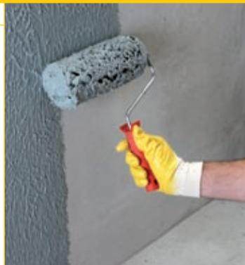
**Двухкомпонентный эластичный состав на цементной основе для гидроизоляции бетона, подверженного положительному или отрицательному гидростатическому давлению.**
