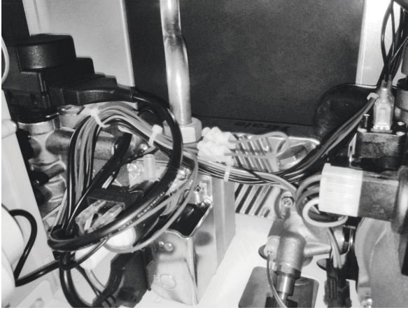
рис. 7 – Доступ к клеммной панели
