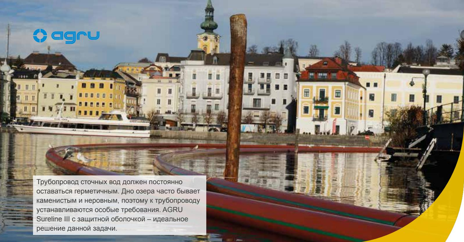
Трубопровод сточных вод должен постоянно оставаться герметичным. Дно озера часто бывает каменистым и неровным, поэтому к трубопроводу устанавливаются особые требования. AGRU Sureline III с защитной оболочкой – идеальное решение данной задачи.
