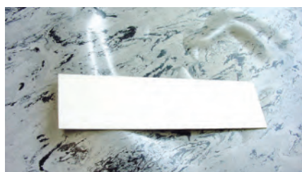
Рис. 11. Образование пузырей при несоблюдении требований по укладке
