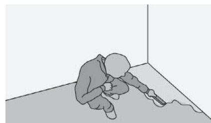
Рис. 21. Выравнивание оснований
