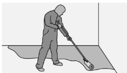
Рис. 20. Грунтование стяжки
