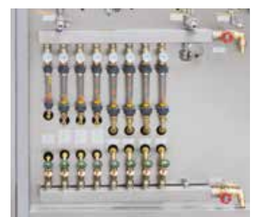
Распределение охлаждающей воды
