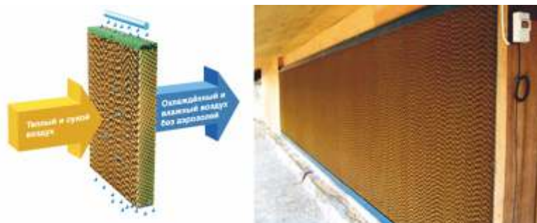
Принцип работы и пример кассет охлаждения
