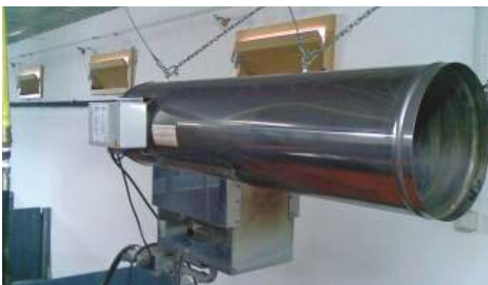
Обогрев с помощью газовых воздухонагревателей
