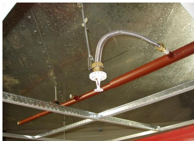
**4.** Закрепить вторую муфту гибкой UL подводки на питающем трубопроводе
