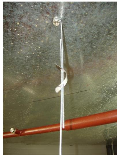
**2.** Закрепить на потолке с помощью дюбеля подвес оросителя.
