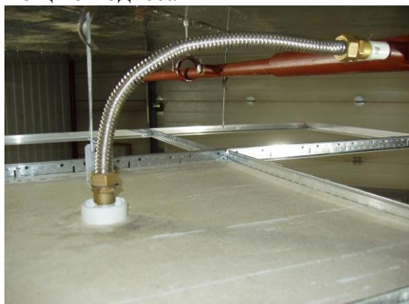
**7.** После установки фрагмента подвесного потолка зафиксировать держатель оросителя патроном
