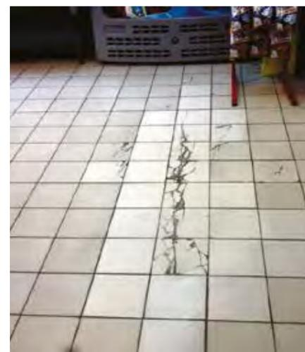
Последствия неправильного выбора или отсутствия деформационных швов
