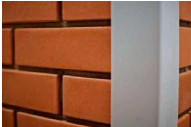
Стыковка внешнего угла с применением уголка
