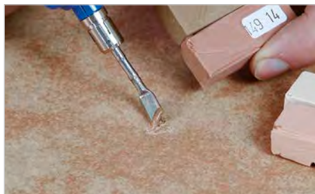
Füllstoff schmelzen, einbringen ... | melt filler, work it in ...
