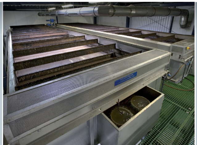
DAF 30 – Flotationsanlage DAF 30 – флотация растворённым воздухом
