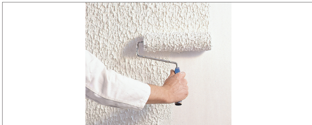
Нанесение Capa-Rollputz с помощью валика.
