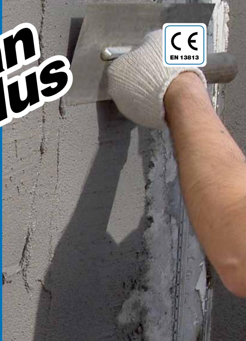
**Состав на цементной основе для выравнивания стен, потолков и полов внутри и снаружи помещений**
