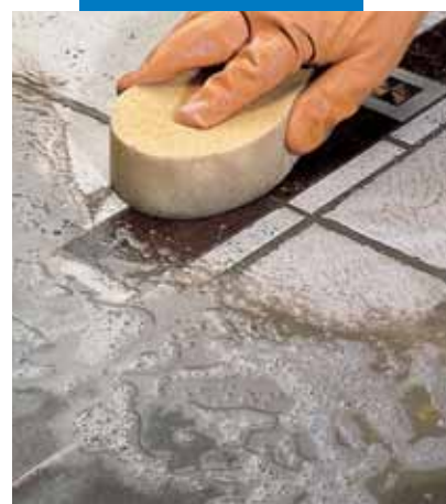
Отделка губкой керамического пола с деревянной вставкой
