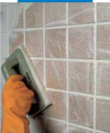
Отделка плитки одинарного обжига теркой Scotch-BriteR
