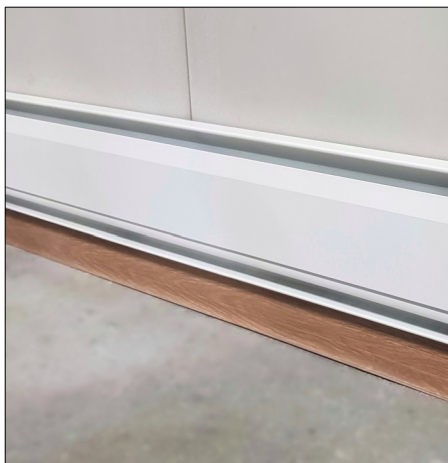
Рисунок 2. Крепление Прибора к стене над декоративным плинтусом.
