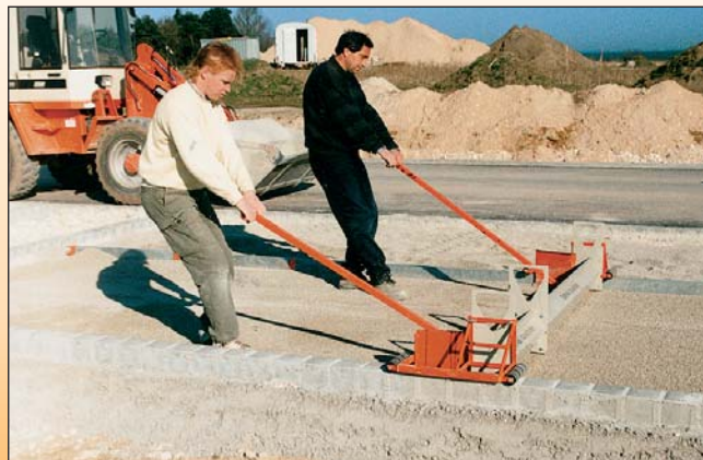
Варианты использования ходовых механизмов: одна сторона катится по бордюрным блокам, другая по нивелировочным шинам.
