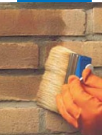
Нанесение Antipluviol S кистью
