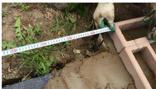
Рис 6. Замер расстояния между столбиками первого ряда «Т-блока» перед их укладкой на раствор
