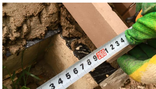
Рис 6. Замер расстояния между столбиками первого ряда «Т-блока» перед их укладкой на раствор
