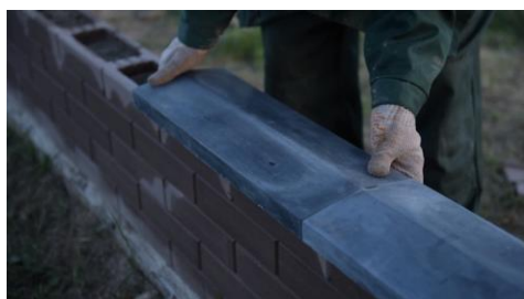
Рис 12. Установка накрывочных элементов на пролет и столб забора
