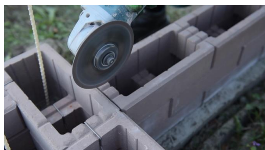
Рис 6. Пропил места крепления столбового и пролетного «Т-блока», скрепление скобой
