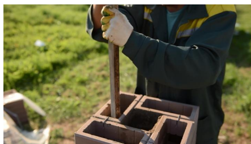
Рис 11. Трамбовка бетона, залитого в столбик из «Т-блока»
