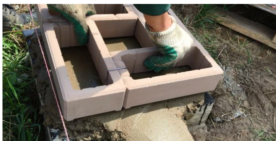
Рис 5. Установка столбика из «Т-блока» на кладочный раствор с использованием уровня
