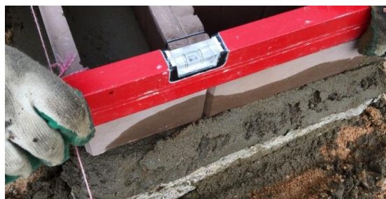
Рис 5. Установка столбика из «Т-блока» на кладочный раствор с использованием уровня
