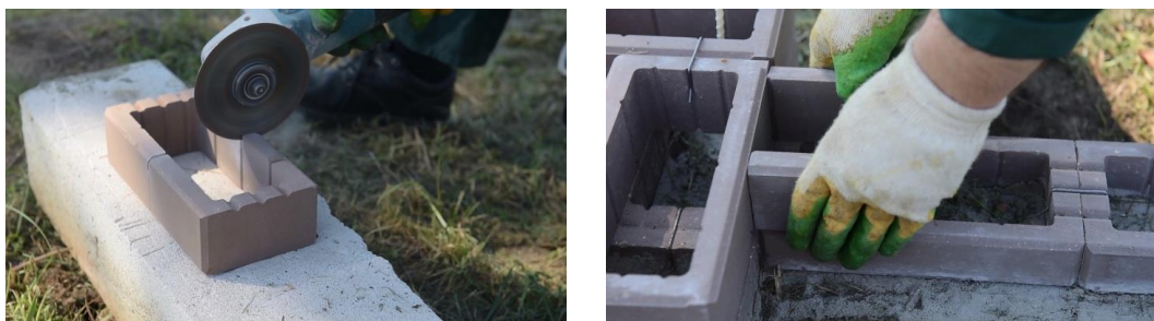
Рис 8. Распил пролетного «Т-блока» на половинки и их монтаж
