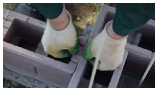
Рис 6. Пропил места крепления столбового и пролетного «Т-блока», скрепление скобой
