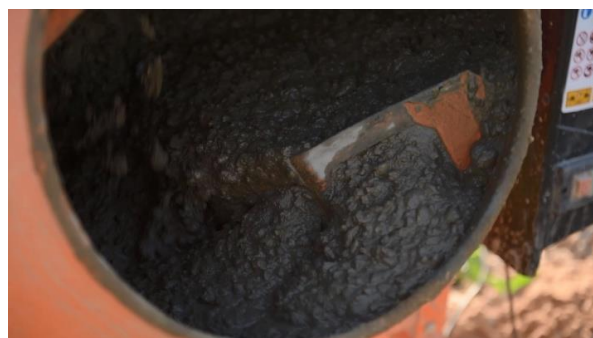
Рис 9. Приготовление бетона для последующей заливки в «Т-блок»
