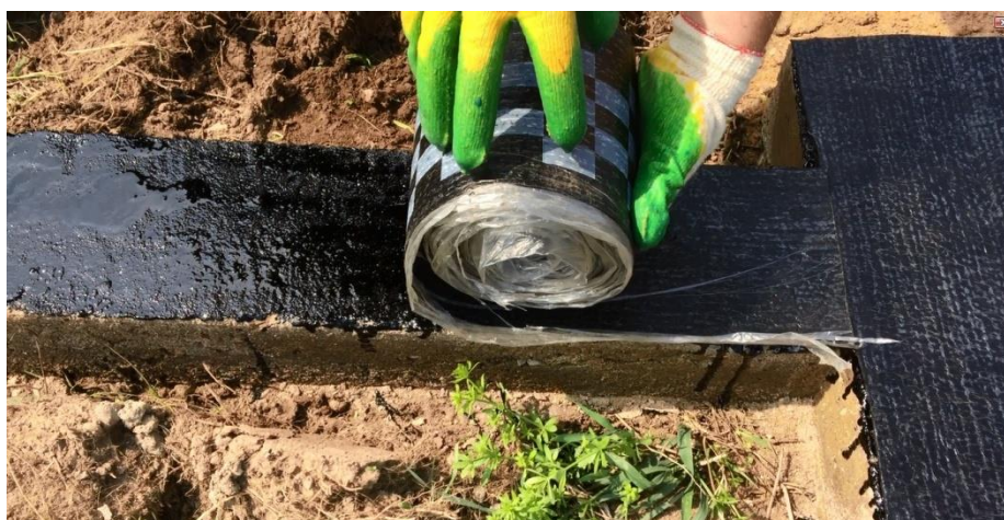
Рис 3. Оклейка фундамента заранее нарезанной гидроизоляционной пленкой
