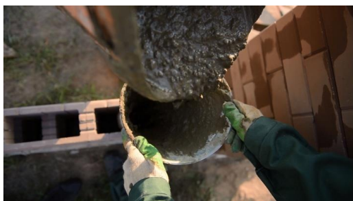
Рис 10. Заливка бетона в пролет забора из «Т-блока»
