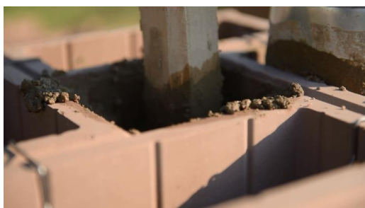
Рис 11. Трамбовка бетона, залитого в столбик из «Т-блока»
