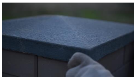
Рис 12. Установка накрывочных элементов на пролет и столб забора
