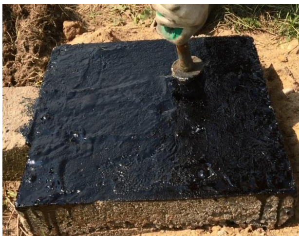
Рис 2. Нанесение слоя мастики (праймера) на фундамент
