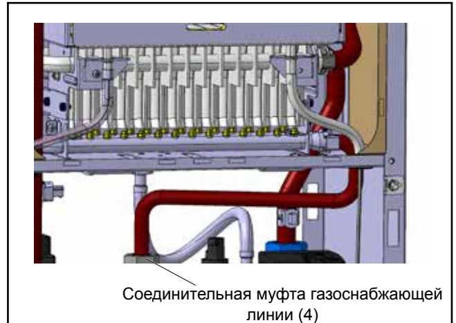
Рис.: Очистка газовой горелки
