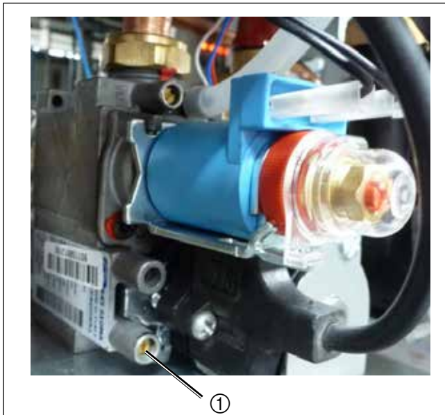
Рис. Комбинированный газовый клапан
