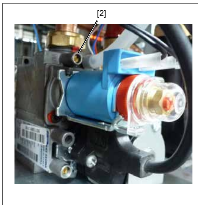
Рис. Штуцер для измерения давления в сопле
