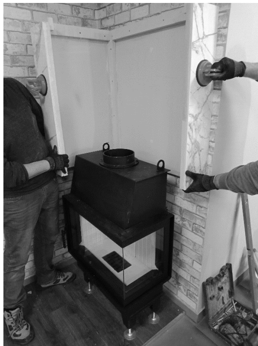
Rysunek 5. Sposób ułożenia pierwszego modułu.
