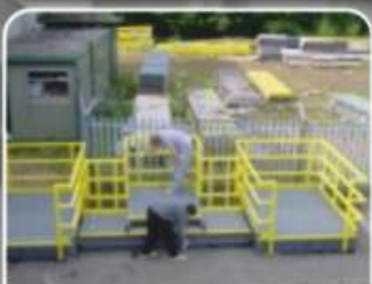
Палубы тех. сооружений
