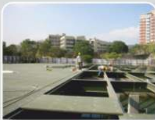
Временные покрытия при реконструкции и ремонте
