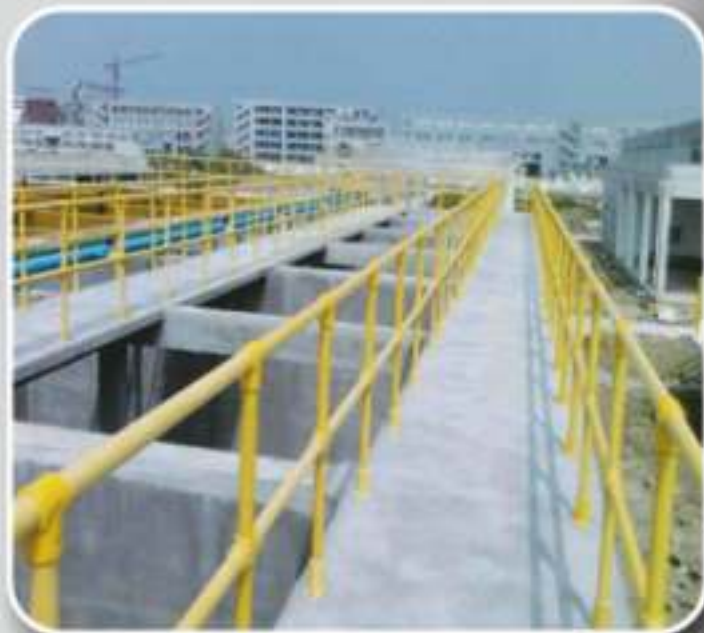
Поручни на водоочистных сооружениях
