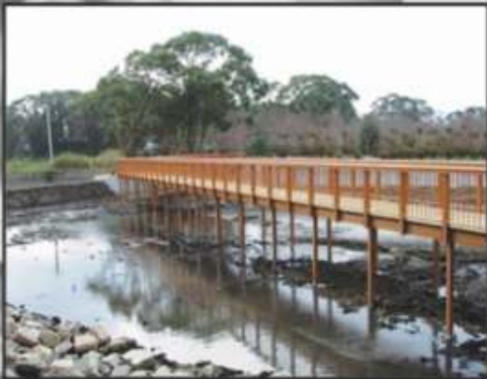
Мосты и переходы
