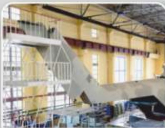
Леса и подмостя
