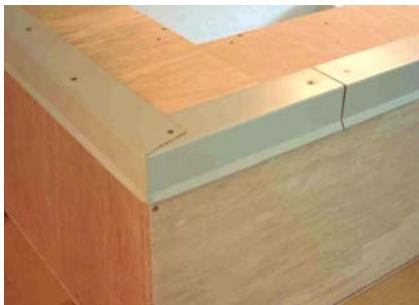
Для изоляции внешнего угла парапета со стороны фасада из металлического листа с ПВХ-покрытием **ALKORPLAN 81170** нарезаются полосы необходимой ширины, формируются в профили нужной конфигурации (капельники),гибаются под прямым углом по длине профиля и механически закрепляются на внешнем угле парапета.
