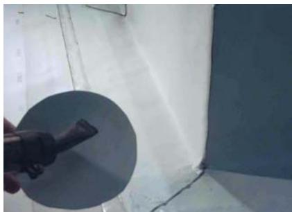
Мы рекомендуем применять готовые угловые накладки, однако, возможно самостоятельно изготовить накладку из не армированной мембранны **ALKORPLAN D 35X71** на объекте.
