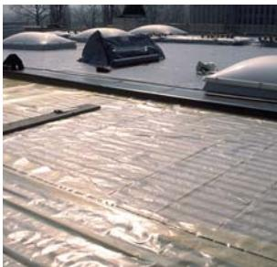
Выбор толщины пароизоляционной пленки рассчитывается для каждого объекта индивидуально в зависимости от предъявляемых требований. Мы рекомендуем применять в качестве пароизоляционного слоя материал **ALKORPLUS 81012** с нахлесткой не менее 100 мм. Пленка укладываются под слоем теплоизоляции, фиксируется на парапетах и деталях с помощью склеивающей крепежной ленты, например, **ALKORPLUS 81057**.
