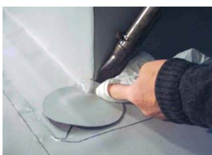
...и проваривают вначале в местах перегибов, а затем на вертикальной поверхности...
