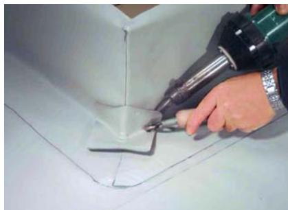
...и проваривают вначале в местах перегибов, затем на вертикальной поверхности и по всей остальной поверхности накладки.
