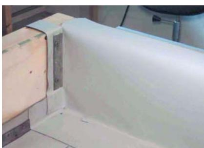
...а затем и по всей горизонтальной поверхности. Мембрана механически закрепляется на парапете.
