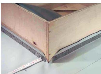
На горизонтальной поверхности кровли на расстоянии 100 мм от стены или парапета наносятся риски.
