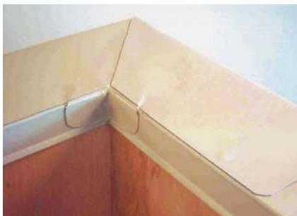
Внутренний угол профиля из металлического листа с ПВХ покрытием **ALKORPLAN 81170** заваривается полосой шириной 20 см из не армированной мембраны **ALKORPLAN D 35X71**.
