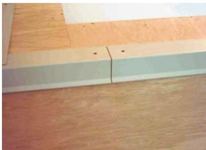
Профили крепятся между собой с интервалом из расчета 2 мм на каждый погонный метр длины металлического листа.
