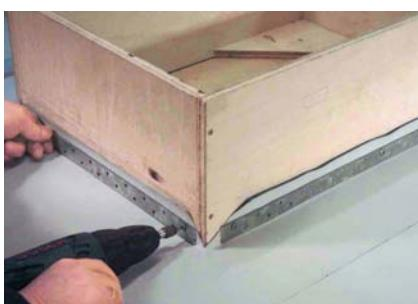
... механически закрепляется с помощью металлической рейки.
