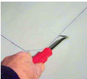
Качество сварного шва проверяют не ранее, чем через 30 минут после сварки:
