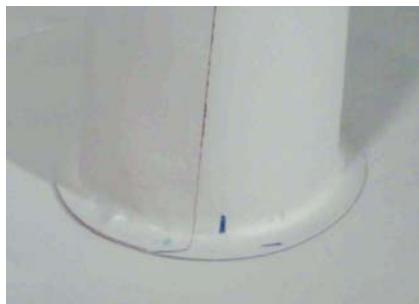
После этого подготовленная трубка из мембранны натягивается на изолируемую трубу...
