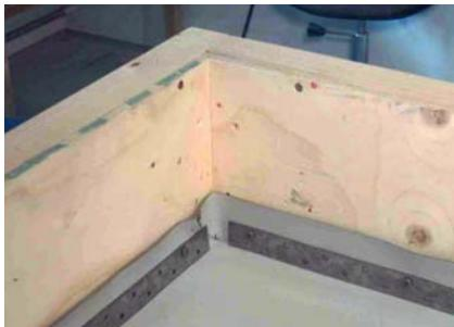
Как уже было отмечено в п. 4.2. при устройстве примыканий кровли к вертикальным поверхностям мембрана **ALKORPLAN** заводится с горизонтальной на вертикальную или наклонную поверхность на высоту не менее 50 мм и механически закрепляется с помощью металлической рейки.
