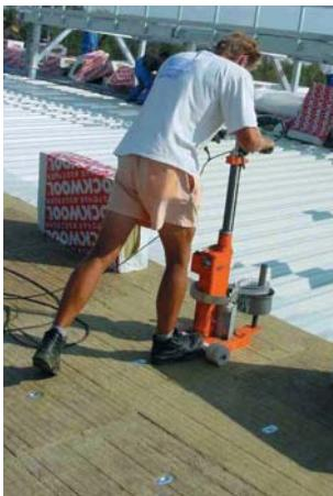
Теплоизоляционные плиты укладываются поверх пароизоляционного слоя и крепятся к основанию под кровлю в соответствии с рекомендациями её производителя. Как правило, теплоизоляцию из минераловатных плит укладывают в два слоя: нижний слой – с меньшей плотностью, верхний слой – с большей плотностью.
