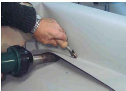
Полоса мембранны надежно закрепляется на парапете, опускается вниз с нахлестом в 100 мм на горизонтальную поверхность кровли, проваривается в месте перегиба мембранны...
