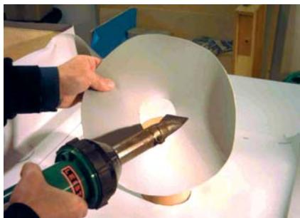
Ручным феном разогревается внутренняя окружность кольца на ширину сопла 40мм, растягивается вручную...
