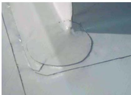
Вид полностью изолированного внешнего угла при помощи не армированной мембранны **ALKORPLAN D 35X71**.
