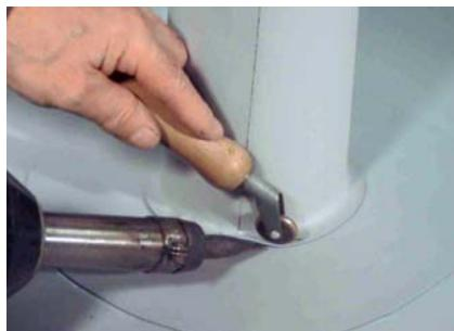
...и приваривается внизу к горизонтальному кольцу с использованием узкого металлического прикаточного ролика.
