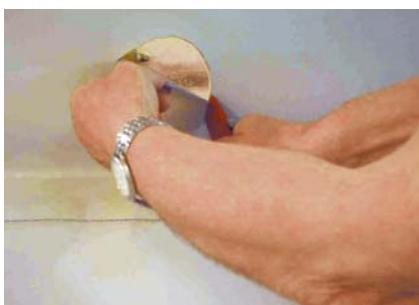
У водосточной трубы в мембране вырезается отверстие немногим больше диаметра трубы.
