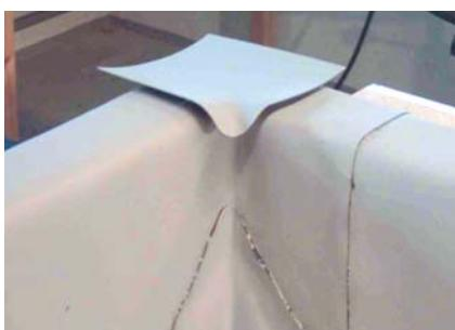
Завершают изоляцию угла парapета, устанавливая накладку на внутренний угол парapета со стороны фасада.
