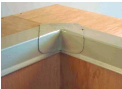
Для изоляции внутреннего угла парапета со стороны примыкания кровли из металлического листа с ПВХ-покрытием **ALKORPLAN 81170** нарезаются полосы необходимой ширины, формируются в профили нужной конфигурации (капельники),гибаются под прямым углом и механически закрепляются на внешнем угле парапета.
