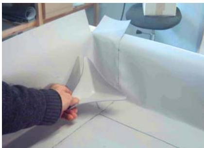
Для его надежной герметизации мы рекомендуем применять готовые накладки внутреннего угла **ALKORPLAN 81060**, однако возможно применять и накладки из не армированной мембранны **ALKORPLAN D 35X71**.
