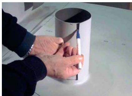
Для изоляции вертикальной поверхности трубы вырезается полоса из не армированной мембранны **ALKORPLAN D 35X71** шириной, равной высоте изолируемой поверхности, но не менее 150мм, и длиной на 50 мм больше длины окружности трубы. Полоса мембранны примеряется на трубе, отмечается рисками положение свернутой вокруг трубы мембранны...
