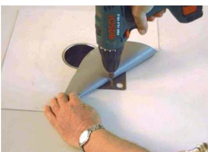
Водоприемная воронка устанавливается на водосточную трубу и механически закрепляется к основанию кровли (не менее четырех крепежей на одну воронку).
