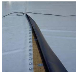
На одном погонном метре по периметру используют не менее 4 крепежных элементов.
