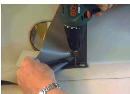
В это отверстие вставляется водоприемная воронка и механически закрепляется к основанию кровли (не менее четырех крепежей на одну воронку) и к парапету (не менее двух крепежей на одну воронку).
