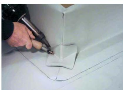
Накладку устанавливают на герметизируемый угол, фиксируют...
