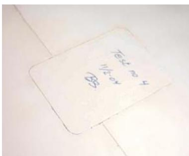
Участок, из которого был вырезан образец, заваривают предварительно подготовленным куском мембранны – заплатой, где отмечают номер испытания, дату, подпись кровельщика.
