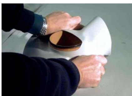
...сразу же, пока не остыла мембрана, натягивается на трубу до горизонтальной поверхности кровли.
