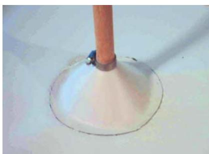
...а верхняя часть конуса затягивается металлическим хомутом и заливается герметиком.
