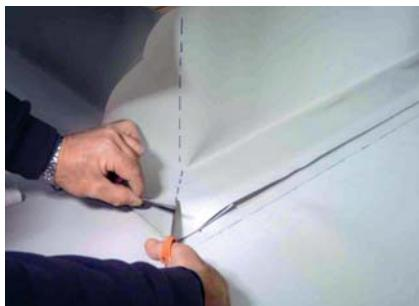
Затем мембрана разрезается и провариваются горизонтальные поверхности.
