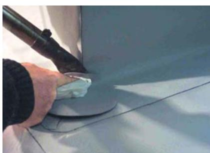
...накладывают его на герметизируемый угол, фиксируют...
