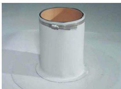
Верхняя часть трубы обжимается металлическим хомутом и заливается герметиком.
