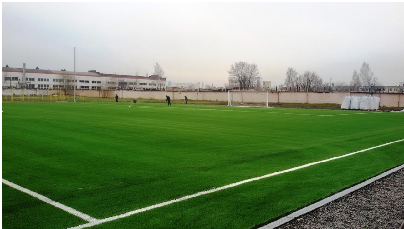
Футбольное поле с искусственным травяным покрытием, высота ворса 50 мм. («LIMONTA MAX S 50», Италия). ЗАО «Футбольная школа Николая Мурашко», г. Минск.
