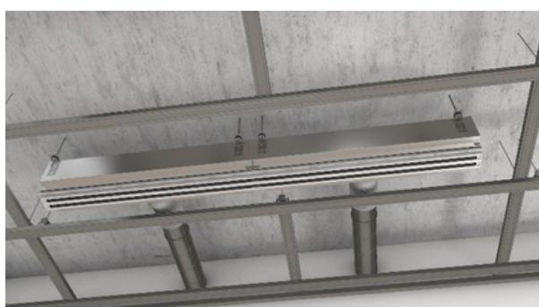
В этом примере два щелевых диффузора соединены вместе бесшовно, хотя камеры КСД работают отдельно. Это позволяет использовать их универсально, когда одна КСД может быть отведена для вентиляции, а другая используется для охлаждения или кондиционирования.
