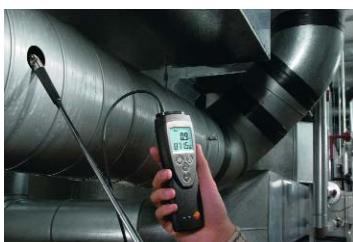
Анемометр с крыльчаткой 16 мм **testo 416\*\***
