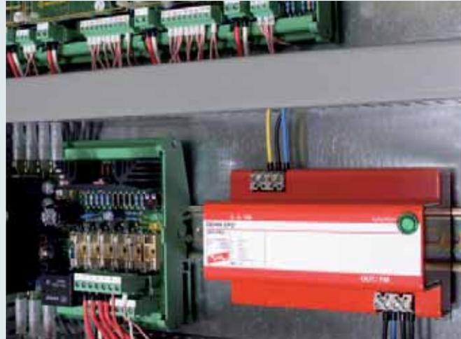
Для защиты сетей электропитания промышленных электронных систем (например, программируемых логических контроллеров (ПЛК)) от импульсных перенапряжений и высокочастотных помех. Для применения согласно зонной концепции молниезащиты на границах МЗЗ 1-2 и выше.
