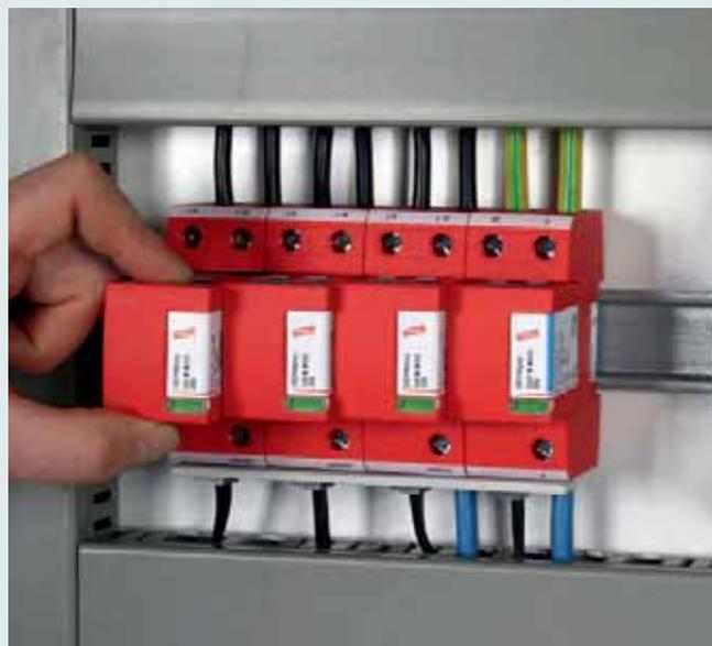
**DB M MOD ...:** сменный модуль на основе искрового промежутка для фазных проводников
