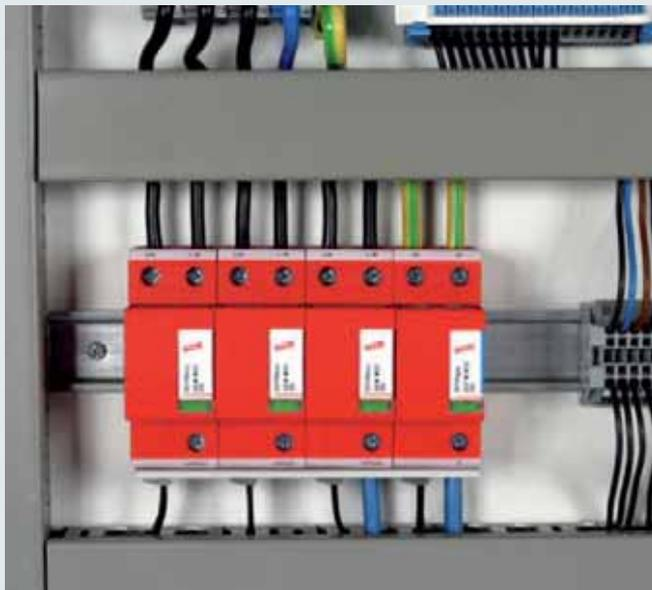
Для защиты низковольтных устройств потребителей от импульсных перенапряжений, даже в случае прямых ударов молнии. Для применения согласно зонной концепции молниезащиты на границах МЗЗ  $0_A - 1$ .
