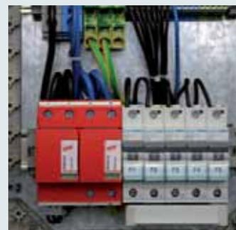
Благодаря запатентованной технологии RADAX Flow для ограничения и гашения сопровождающего тока достигается непрерывность электроснабжения защищаемых электроустановок. Даже при значительных токах короткого замыкания вплоть до 50 kA<sub>ms</sub> возникающие сетевые сопровождающие токи снижаются настолько сильно, что селективность обеспечивается даже при малых номиналах предохранителей, т. е. вводные предохранители не срабатывают из-за возникающего сетевого сопровождающего тока.
