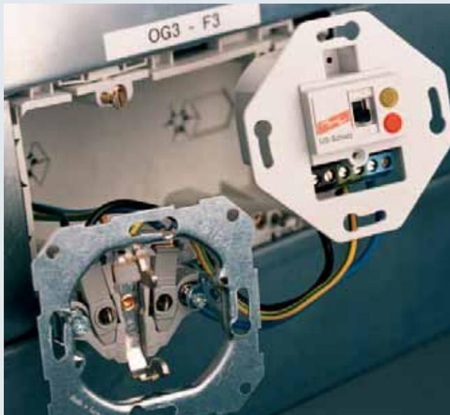
Для защиты электронных приборов от импульсных перенапряжений. Для монтажа в кабельные короба или подрозеточные коробки. Для применения согласно зонной концепции молниезащиты на границах МЗЗ 1-2 и выше.
