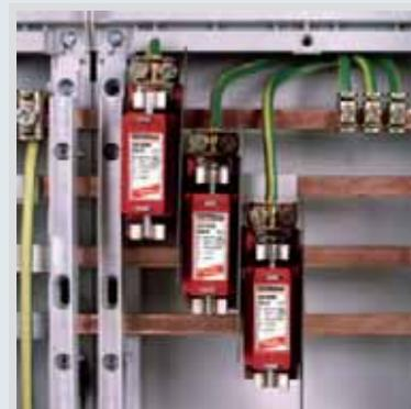
Разрядник тока молнии DB NH00 255 H, смонтированный на сборных шинах ГРЩ
