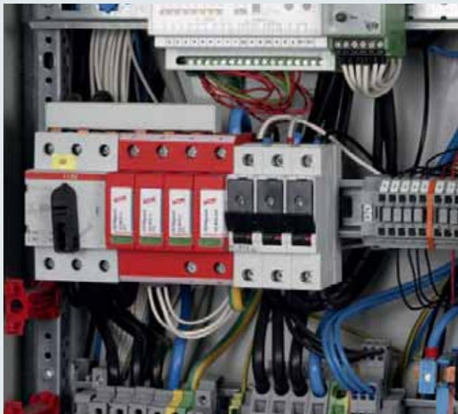
Для защиты низковольтных устройств потребителей от импульсных перенапряжений. Для применения согласно зонной концепции молниезащиты на границах МЗЗ 0<sub>B</sub> – 1 и выше.
