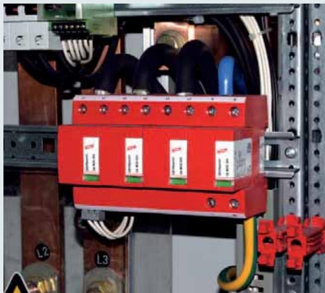
Для защиты низковольтных устройств потребителей от импульсных перенапряжений, даже в случае прямых ударов молнии. Для применения согласно зонной концепции молниезащиты на границах МЗЗ  $0_A - 2$ .
