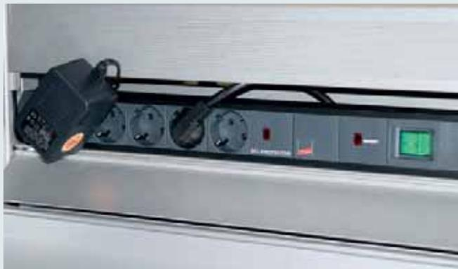
УЗИП с сетевым фильтром для защиты сетей питания электронных приборов от импульсных перенапряжений и высокочастотных помех. Для применения согласно зонной концепции молниезащиты на границах МЗЗ 1-2 и выше.
