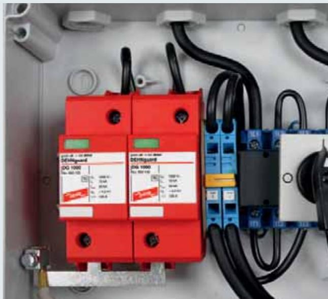
Для защиты низковольтных устройств потребителей от импульсных перенапряжений. Для применения согласно зонной концепции молниезащиты на границах МЗЗ  $0_B - 1$  и выше.
