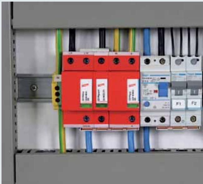
Для защиты низковольтных устройств потребителей от импульсных перенапряжений даже при прямых ударах молнии. Для применения согласно зонной концепции молниезащиты на границах МЗЗ  $0_A - 1$  в схеме подключения "3+1".
