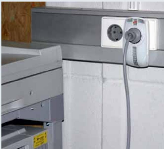
Адаптер для защиты сетей электропитания электронных приборов от импульсных перенапряжений и высокочастотных помех. Для применения согласно зонной концепции молниезащиты на границах МЗЗ 1-2 и выше.
