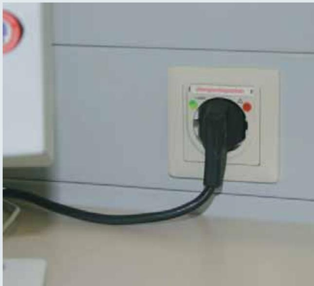
Штепсельная розетка с заземляющим контактом и встроенным УЗИП для защиты электронного оборудования. Для применения согласно зонной концепции молниезащиты на границах МЗЗ 1-2 и выше.
