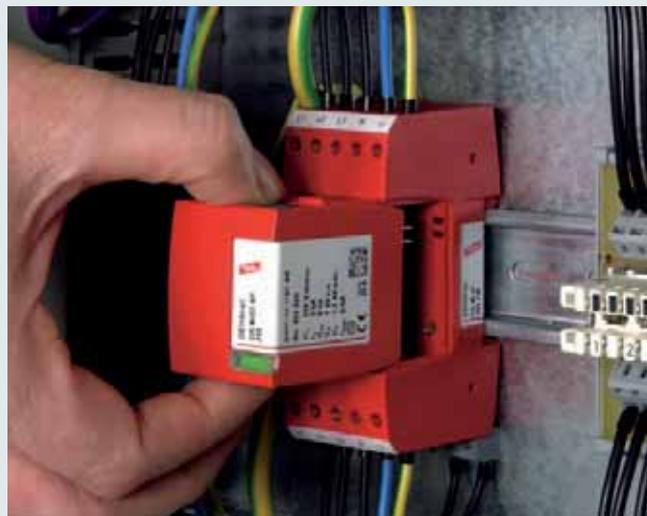
**DEHNrail MOD ...:** для всех типов двухполюсных ограничителей импульсных перенапряжений DR M 2P ...
