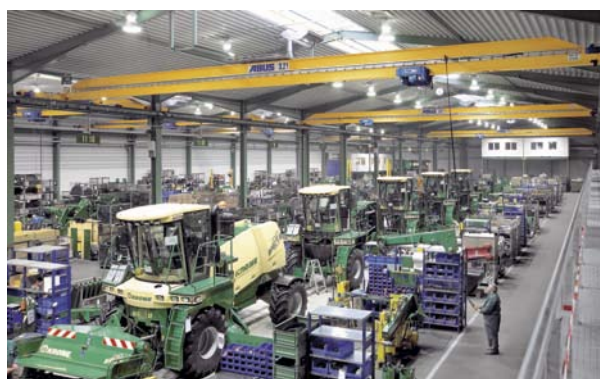
Однобалочные передвижные краны ABUS ELK с канатными электротельферами, тандемным управлением на производстве сельскохозяйственных машин
