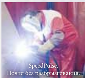
Переходная сварочная дуга – не неизбежность.
