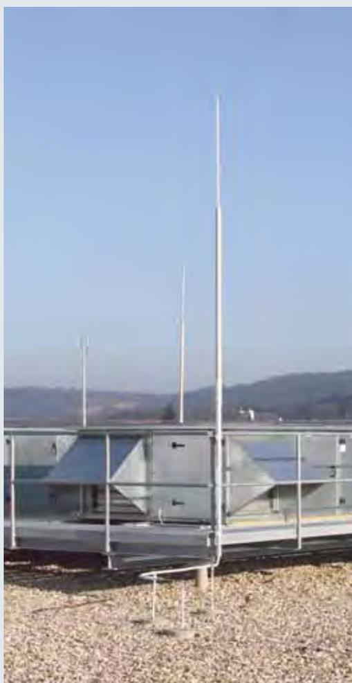
Одиночный молниеприёмник, защищающий оборудование установки обратного охлаждения, выполненный в виде молниеприёмника и HVI® проводника смонтированного внутри изолированной трубостойки
