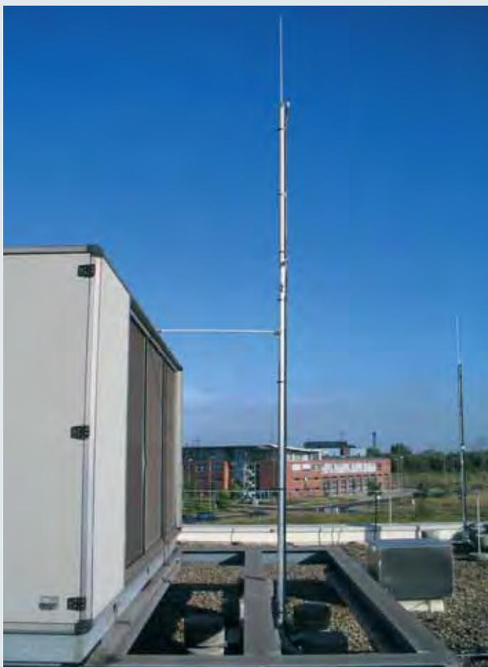
Изолированная система молниезащиты, расположенная около надстройки на крыше, с HVI® проводником.
