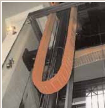
Ascensore. Installazione di catena portacavi colorata Lift. Installation of coloured chain Aufzug. Einbau einer farbigen Schleppkette
