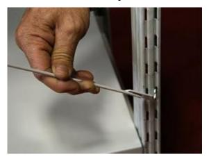
Теперь заведите нижний конец крюка короткого прута в отверстие в нижней части противоположной стойки.
